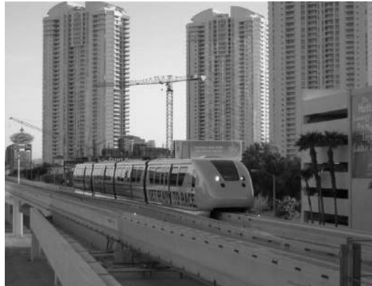
図 2.4.3.1 ラスベガス モノレール 出典：10) 出典：ウィキペディア ラスベガスモノレール
