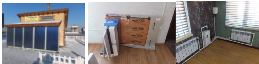
図2.2 グリーンハウスの暖房システムの事例 2013年1月撮影： 太陽パネル，床暖房，電気ヒーター，
