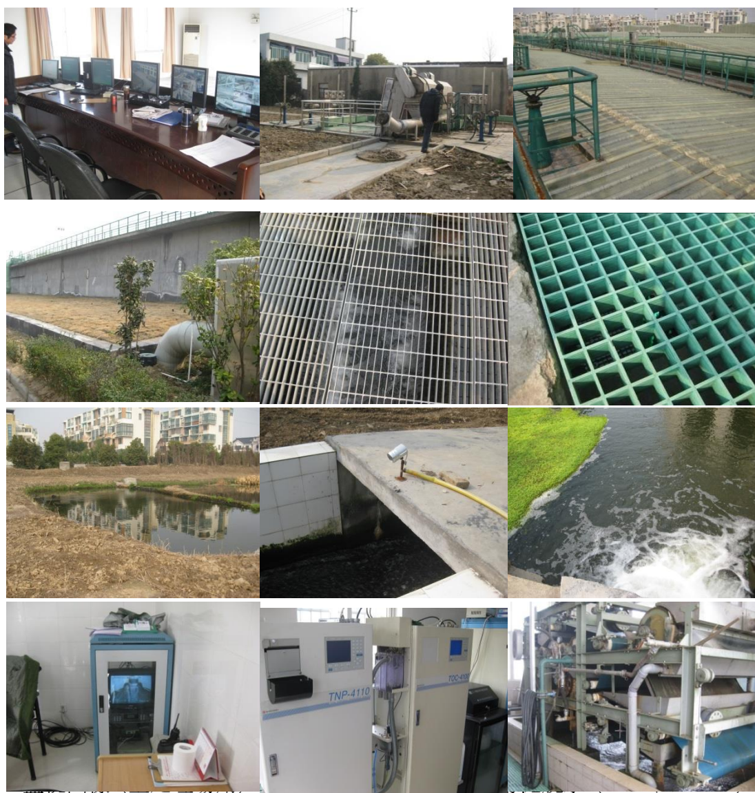
図 2-5 教場山下水処理場
