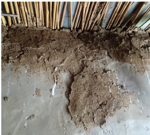
写真 37 肥沃牧草地 B 牛糞を使った屋根の修繕
