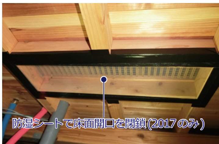
(b) 床下から見た写真
