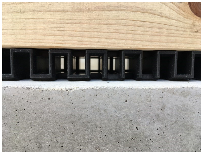
写真1.2 換気用基礎パッキン (株式会社佐藤工業ホームページ 10 )より引用)
