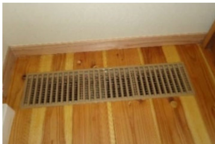
(a) 1階から見た写真
