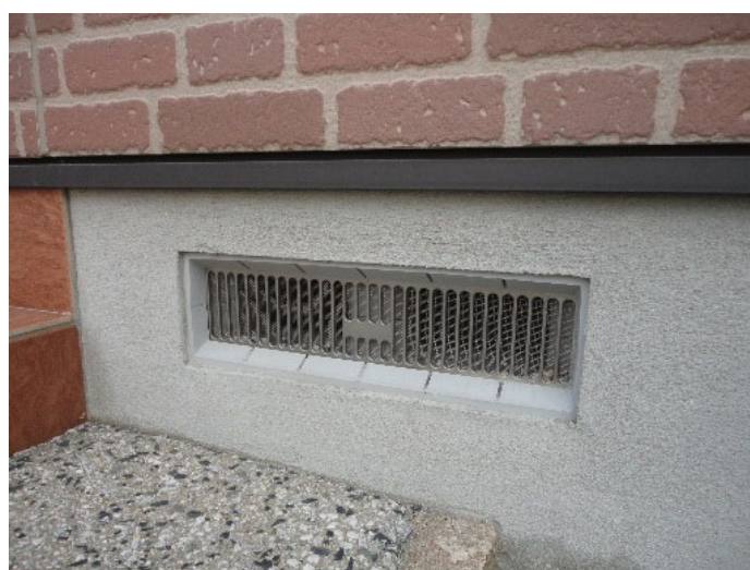
写真1.3 床下換気孔
